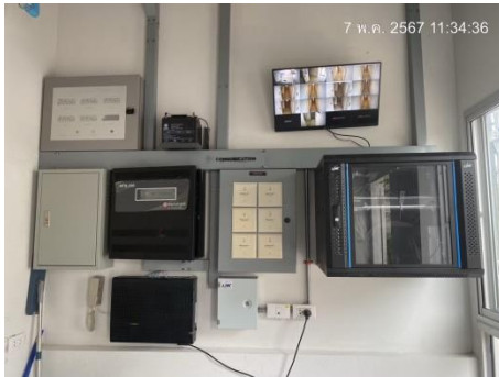
ตู้ควบคุมระบบกล้องวงจรปิด
