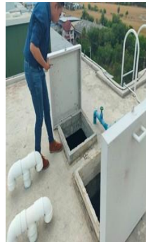
ถังเก็บน้ำสำรองน้ำใช้ดาตไฟฟ้า
